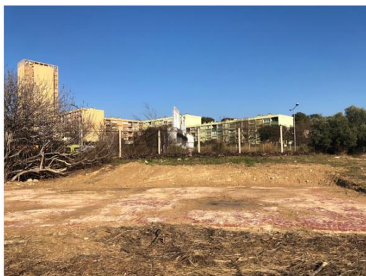
Dalle de l'ancienne chapelle. Le futur bâtiment réservé à l'accueil du public sera construit au dessus
