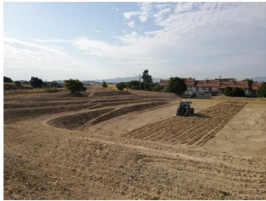
Terrain de la ferme durant le terrassement © Cité de l'Agriculture
