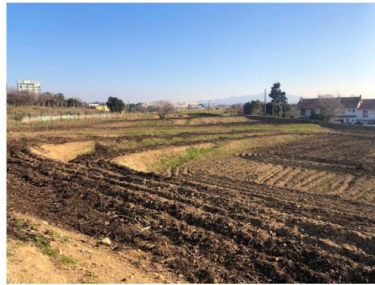
Terrain après le terrassement
