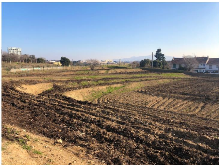
Terrain après le terrassement
